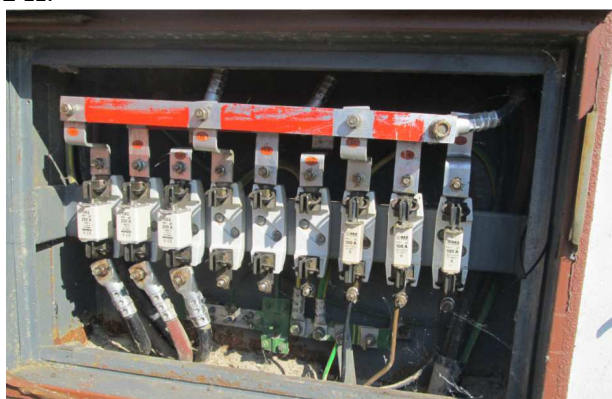
POJISTKOVÁ SKŘÍŇ – UPRAVIT PRO NOVÉ NAPOJENÍ RMS1
